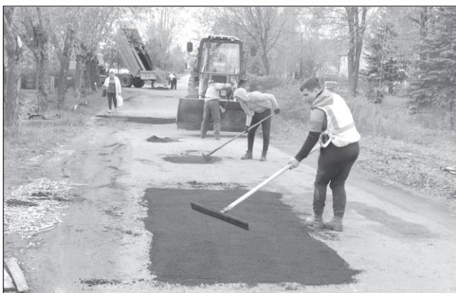
**При ремонте дорог для прочности использовалась асфальтово-бетонная смесь**
